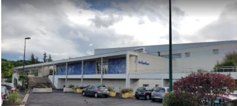
Centre nautique les hautes roches
